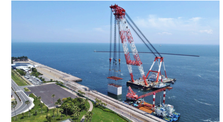
岸壁築造工事
