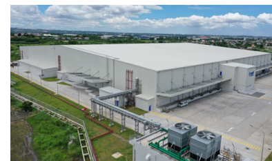
物流倉庫建設
