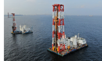
海上地盤改良工事
