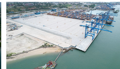
ケニア・モンバサ コンテナターミナル建設
