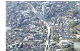
東村山駅付近 連続立体交差事業
